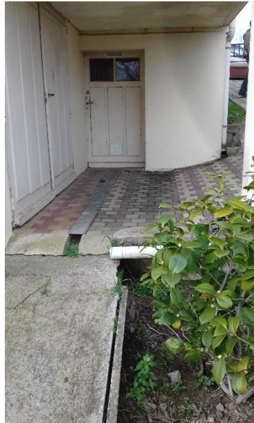
Piège à eau , pour canaliser l'eau sur sa course.
