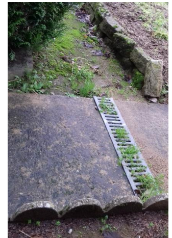
Piège à eau , pour canaliser l'eau sur sa course.
